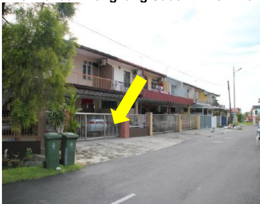
Gambar 1.19 Permukaan Longkang Sudah Dikonkrit
