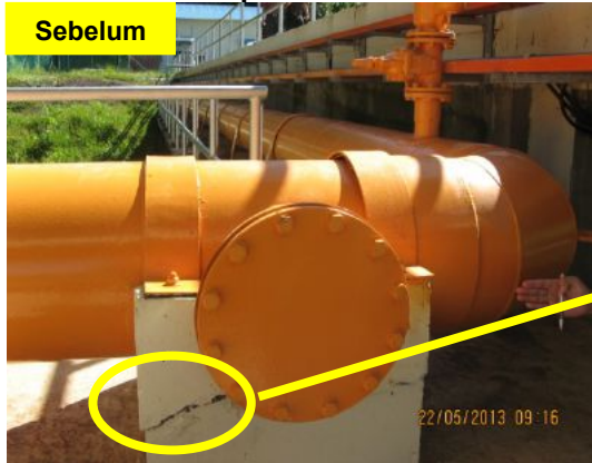
Gambar 3.6 Keretakan RC Support Pada Pumping Paip Air Mentah
