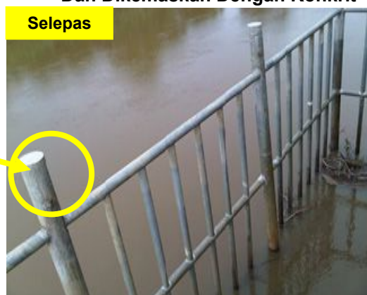
Gambar 3.4 Besi Tetulang Tersebut Telah Dipotong Dan Dikemaskan Dengan Konkrit
