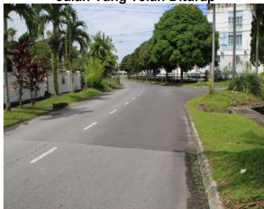
Gambar 1.6 Jalan Yang Telah Diturap
