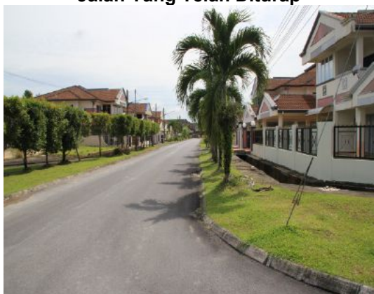
Gambar 1.5 Jalan Yang Telah Diturap
