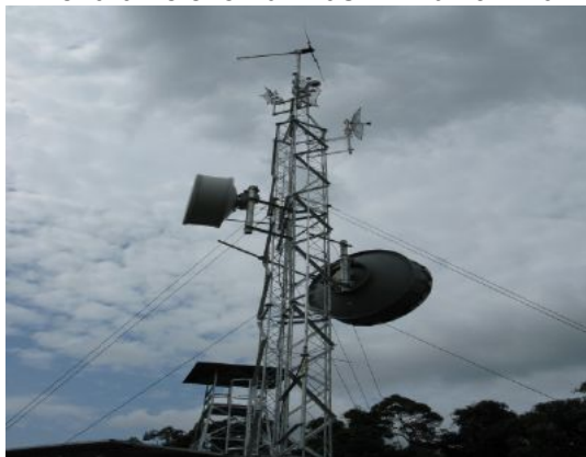
Gambar 5.14 Menara Telekomunikasi Di Bukit Mina
