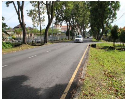
Gambar 1.4 Jalan Yang Telah Diturap
