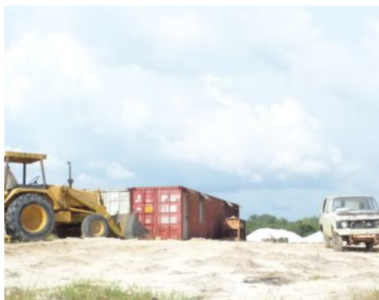
Gambar 2.3 Kerja Penyediaan Tapak Lombong Pasir Silika Sedang Dijalankan
